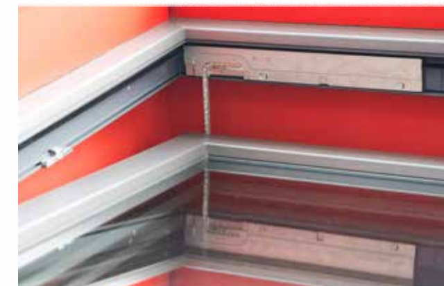
Der motorische Fensterantrieb DRIVE CL bringt auch bei Heimspielen mit hohem Besucherandrang Frischluft in das Gebäude. Er sorgt dafür, dass sich die schwer erreichbaren Oberlichter in der Lounge bequem öffnen und schließen lassen. Durch die Vernetzung mit Sensoren öffnet und schließt er die Oberlichter auch ganz von allein. Dafür muss man genauer hinschauen, denn mit seiner verdeckt liegenden Technik bleibt er dezent im Hintergrund.
